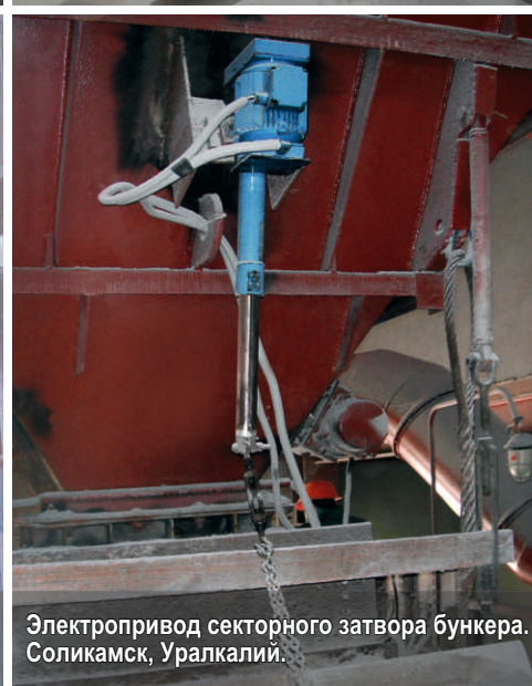
Привод шибера бункера, Соликамск, Уралкалий
